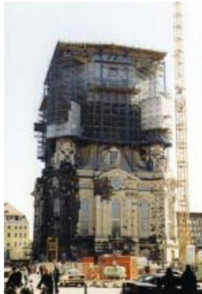
phase das Hünnebeck-Wetterschutzdach mehrfach um einige Meter hydraulisch angehoben werden. Dieses Verfahren entwickelten die Spezialisten von Hünnebeck speziell für den Bau der Frauenkirche. Es ermöglichte, bei jedem Wetter und auch im Winter mit dem Bau fortzufahren.
