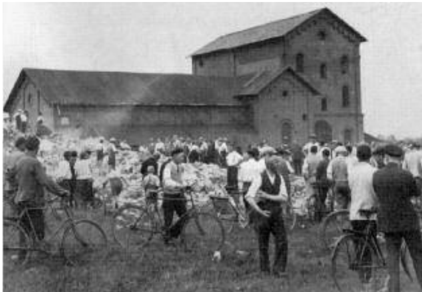
Am 18. Juli 1932 wurde der letzte Schornstein der Lintorfer Zeche niedergelegt. Die Zeit der Arbeitslosigkeit ermöglichte es vielen Lintorfern, dieses Ereignis aus nächster Nähe mitzuerleben
