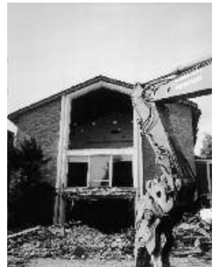
Der Abriss beginnt
