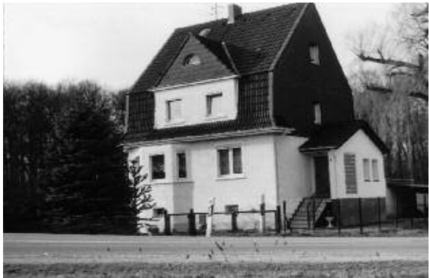
Das Haus „Am Kalter“, Breitscheider Weg 3, in dem die Familie Frohnhoff lebt. Es wurde im November 1944 durch Bombeneinschläge stark beschädigt
