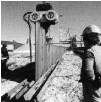
Vibrationsbär zum Einrammen von Spundbohlen im Kanal- und Tiefbau
