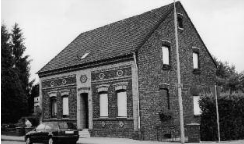
Das Haus Duisburger Straße 36 wurde nach dem gleichen Plan gebaut wie das Haus Am Diebstock 2
