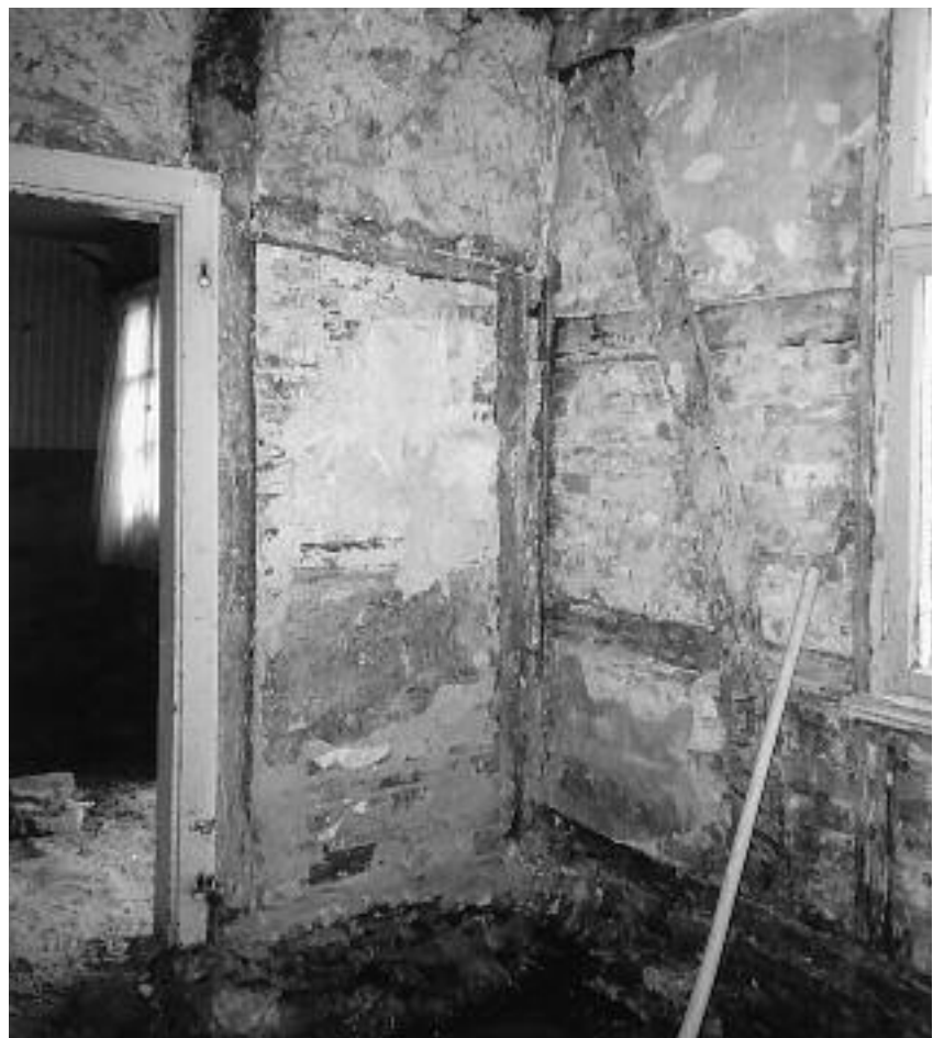
Während der Auskernung des Hauses
