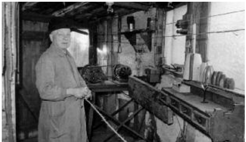
Seilermeister Wilhelm Lindenbeck beim Anfertigen von Seilen in der Seilerbahn. Die Seilerbahn lag hinter dem Geschäftshaus Düsseldorfer Straße 4. Das Foto entstand 1953/54
