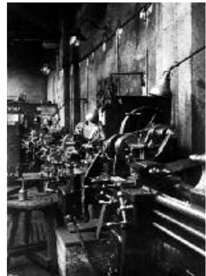
Inneres der Halle an der Mülheimer Straße
