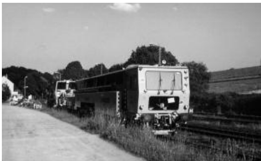
Gleisstopfmaschine 09-32 CSM, dahinter Schnellschotterplaniermaschine SSP 110 am 27.5.1999 in Flandersbach
