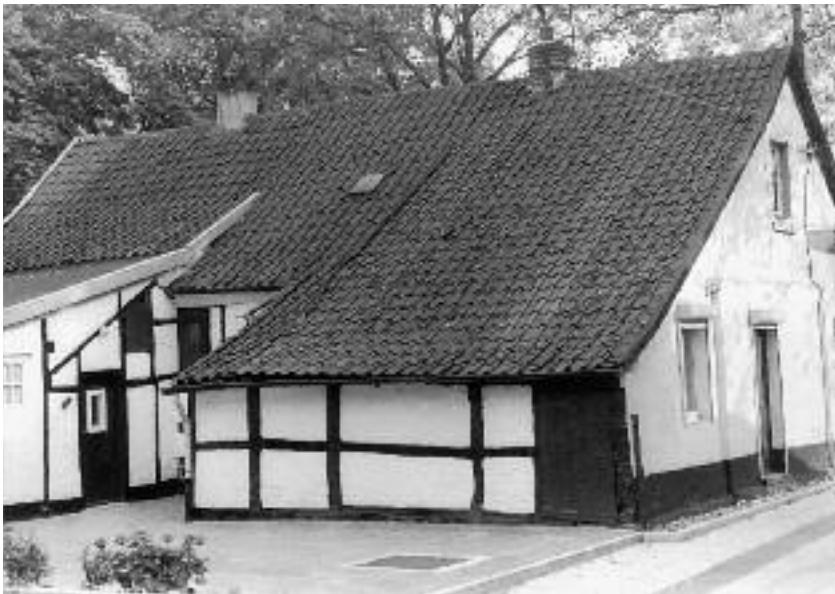
Das Haus Ulenbroich vor der Restaurierung. An der Giebelseite erkennt man die Tür, die zur früheren Leihbücherei führte. Heute würde man durch sie ins Wohnzimmer der Familie Melchert gelangen
