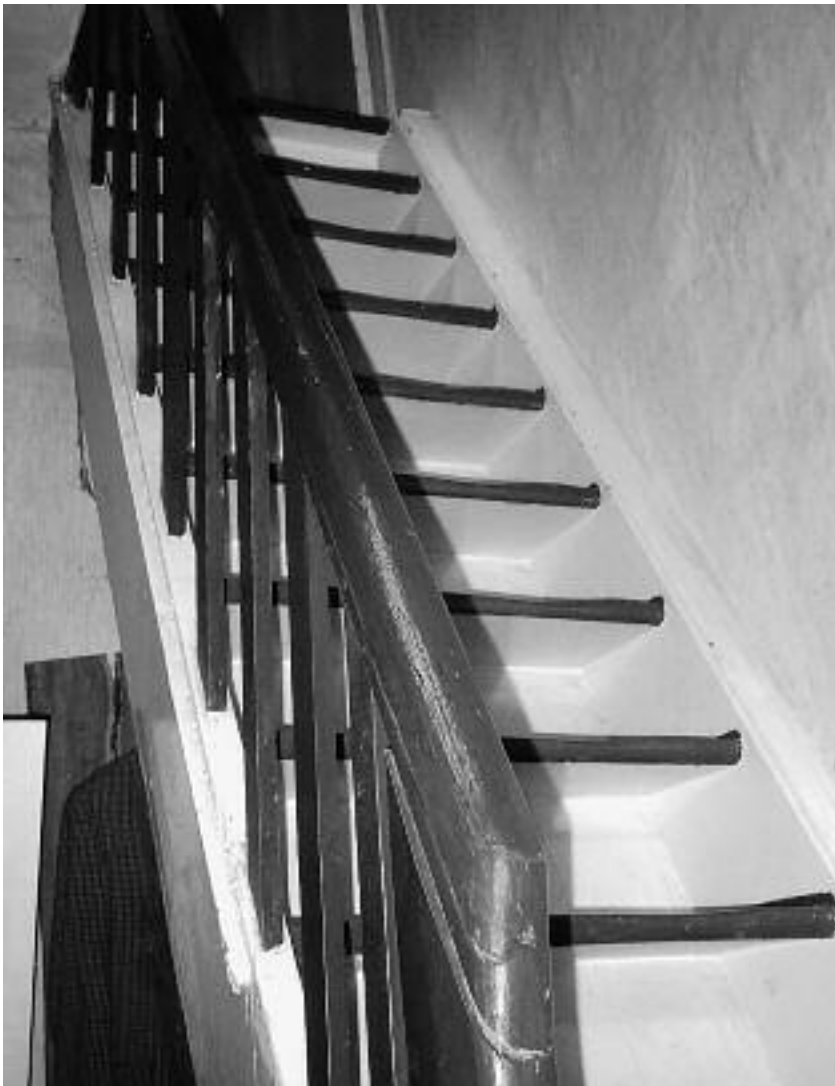
Die alte Treppe, die zu den Schlafgemächern im oberen Stock führt
