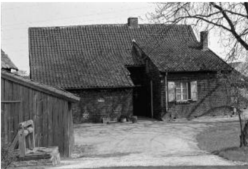
Das kleine Gehöft „An der Heggen“ der Familie Rosendahl. Vorne links vor der Scheune erkennt man den Ziehbrunnen. Das Haus wurde 1979 abgerissen
