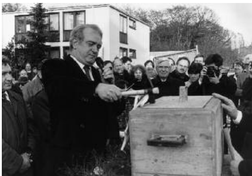
Ministerpräsident Johannes Rau legt am 21. Februar 1991 den Grundstein für den ersten Bauabschnitt von „Salem 2000“
