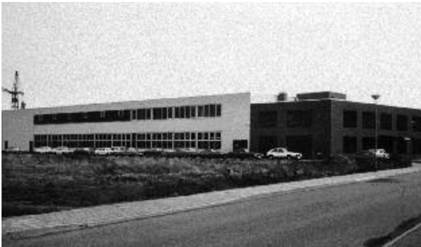
Der Neubau der Firma Tünkers im Tiefenbroicher Industriegebiet Am Rosenkothen
