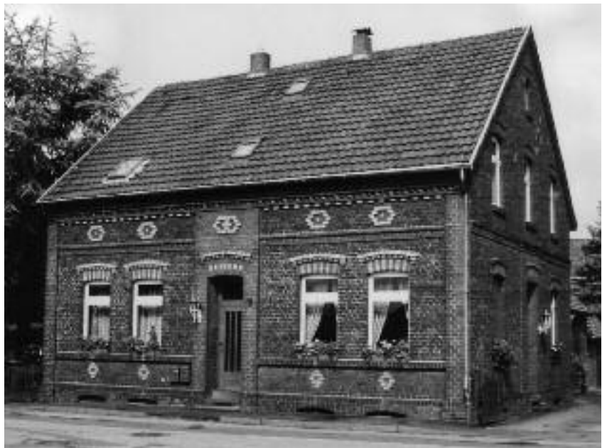
Das Haus Am Diepebrock 2. An der Giebelwand rechts erkennt man den Eingang zur früheren Einliegerwohnung und die beiden Anbauten
