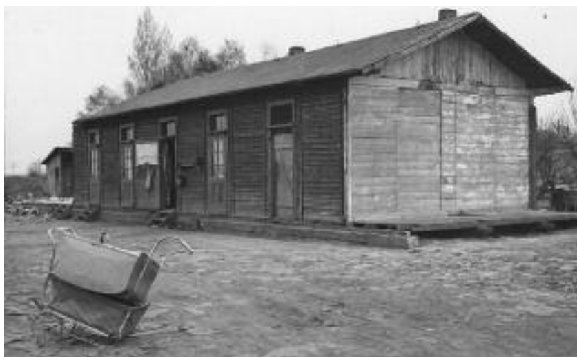
Eine der beiden Baracken, die der Stadt Ratingen bis 1938 als Behelfsheim für Obdachlose dienten
