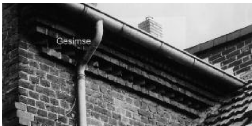
Kunstvoll gemauerter Sims an der Rückwand des Hauses. Auf dem Dach des Anbaues rechts die besagten Ludowitz-Ziegel
