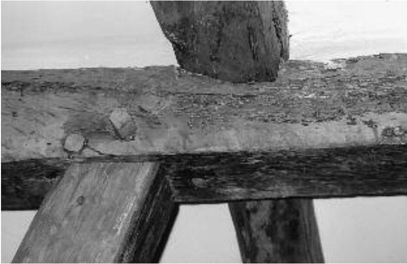
Restaurierte Balken im Wohnzimmer
