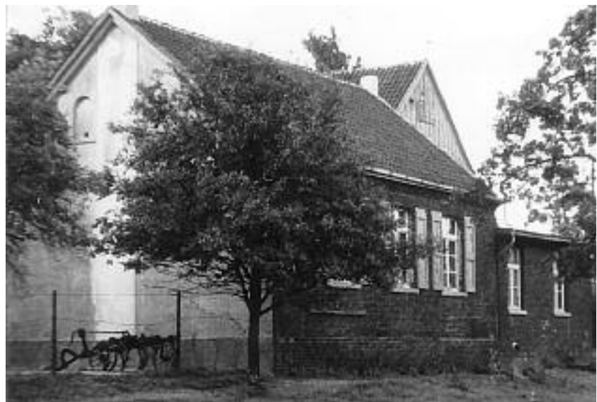
Die evangelische Volksschule Linnep Im Vordergrund der Schulsaal von 1859, rechts davon das erweiterte Schulzimmer von 1817, dahinter der Giebel des alten Lehrerhauses von 1694
