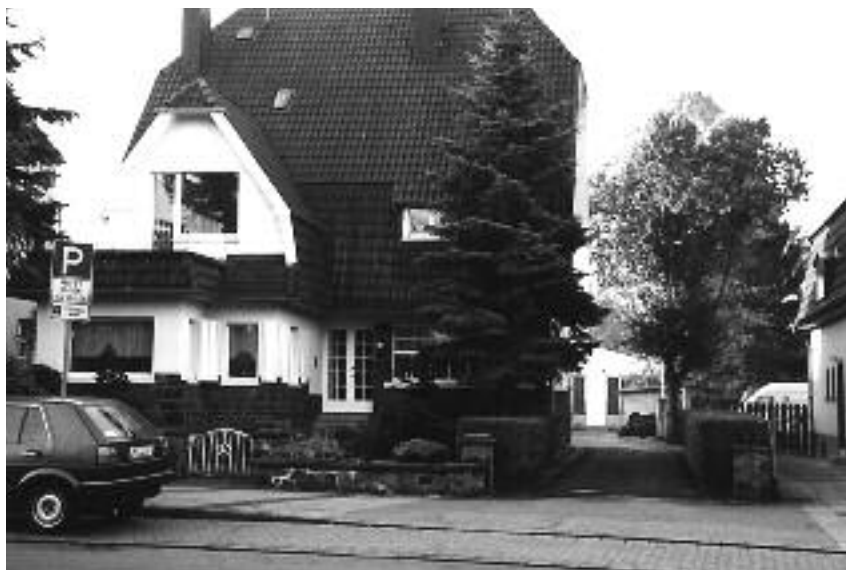
Die Reste der Rheinpreussen-Tankstelle bei Karrenberg/Lange. In der Einfahrt, vor dem Baum, stehen noch die Zapfsäulen
