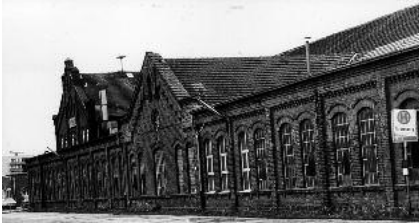
Die Gebäude des früheren Walzwerkes Bredt und Co. wurden nach dem Zweiten Weltkrieg von der Firma Hoffmann übernommen, die hier Fahrräder, Motorräder und die legendäre „Vespa“ herstellte. Heute stehen die Gebäude unter Denkmalschutz und wurden von der Firma Paass GmbH liebevoll restauriert
