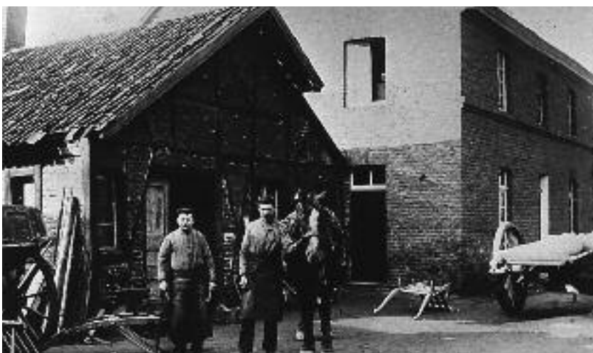
Ludger Klötgen (1879-1952) vor seiner Schmiede an der Angermunder Straße (Konrad-Adenauer-Platz). Im Haus betrieb er eine Eisenwarenhandlung. 1921 übernahm Fritz Füsgen das Haus. Er hatte hier eine Farbenhandlung und später auch eine Drogerie
