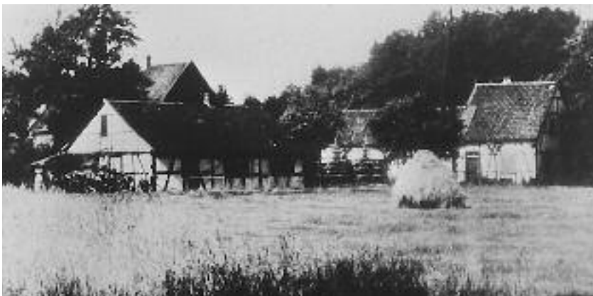
Im Vordergrund links der Kotten Maultsack, dahinter das Haus des Gärtners Eigenbrod. Die Gebäude rechts wurden abgerissen
