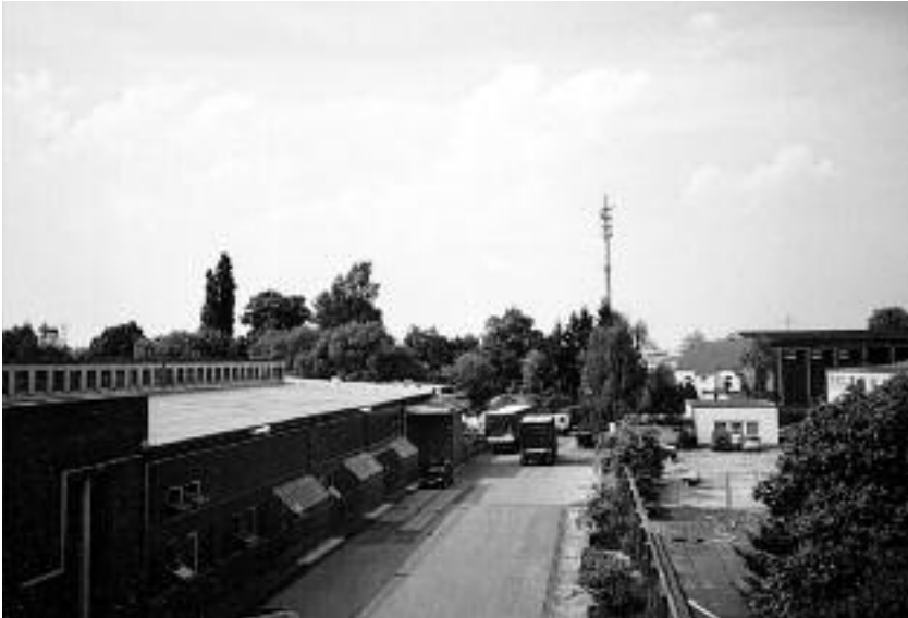
Blick von der Süddakota-Brücke auf das Betriebsgelände der Papierfabrik Tenax. Sie wurde in den 1950er Jahren als Tochtergesellschaft der Papierfabrik Wilderich Graf Spee gegründet. Aus dieser Zeit stammen auch die Fabrikgebäude im Vordergrund. Die Bauten der nicht mehr existierenden Papierfabrik Wilderich Graf Spee wurden abgerissen. Im Hintergrund rechts erkennt man allerdings noch das ehemalige Wohnhaus von Direktor Fritz Offermanns
