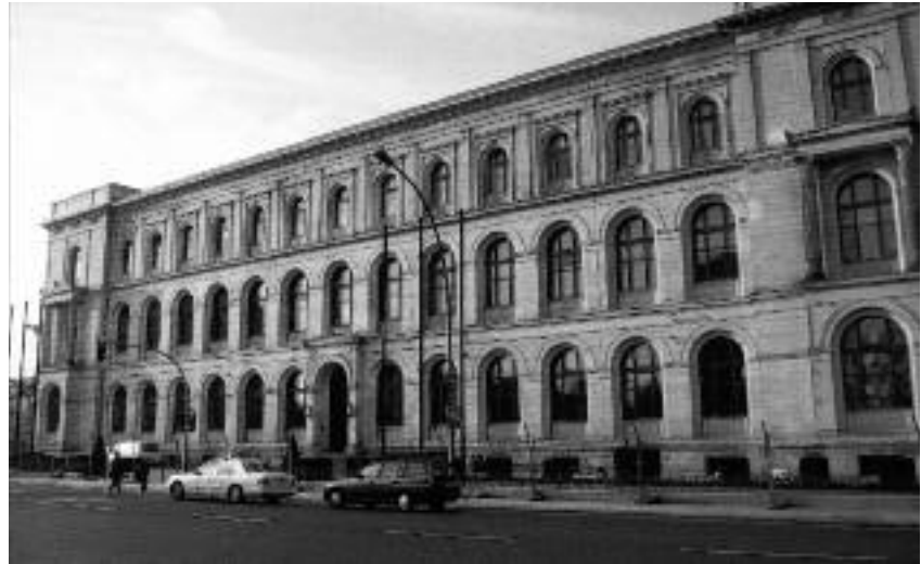
Das Gebäude Invalidenstraße 44 in Berlin-Mitte. Von 1878 bis 1996 war hier die Preußische Geologische Landesanstalt bzw. deren Nachfolgeorganisationen untergebracht
