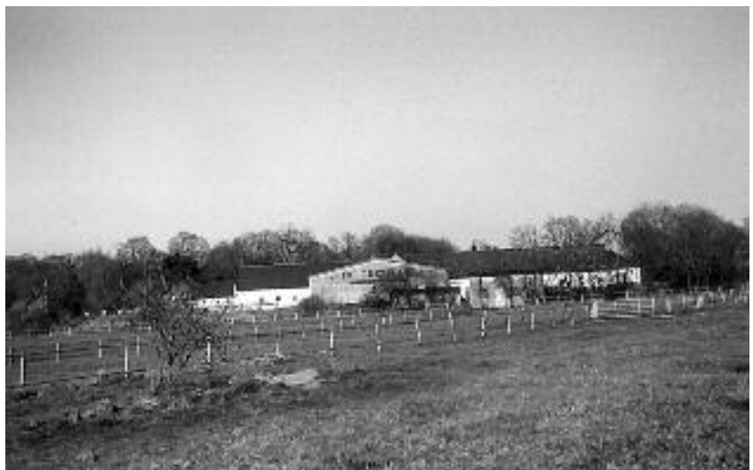
Haus Hülchrath in den 1970er Jahren. Die neue Reithalle des Reitstalles Joh wurde bereits errichtet
