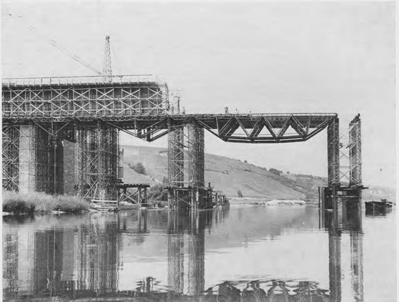
Hünnebeck-Rüstgeräte beim Bau der Mainbrücke bei Dettelsbach 1963
