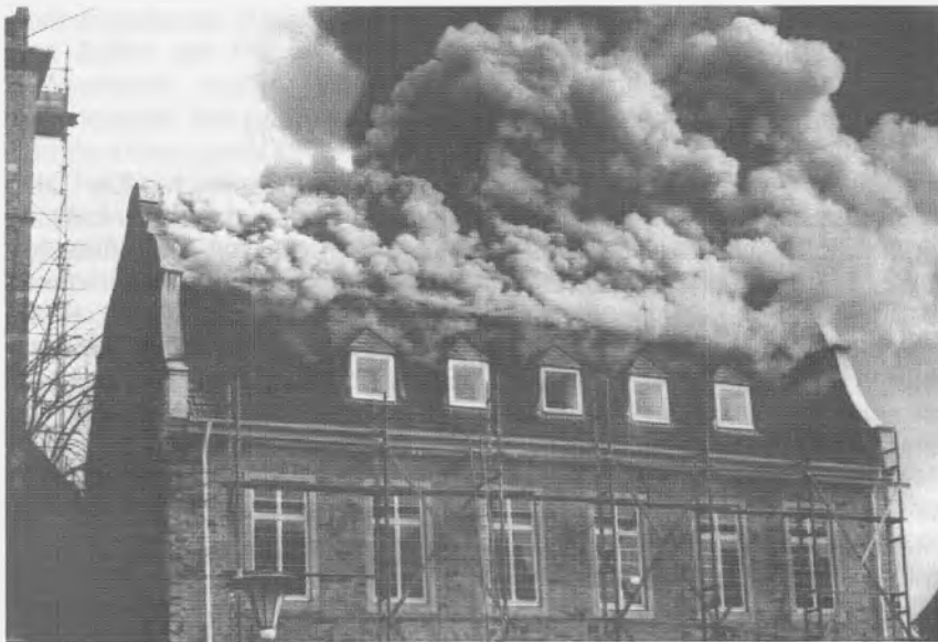
29.02.1972: Der Brand im Bürgerhaus am Markt verzögerte die Eröffnung der fast fertiggestellten Stadtbücherei bis zum Jahresende.
